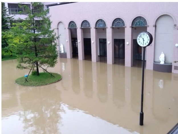
水没した正面玄関前
