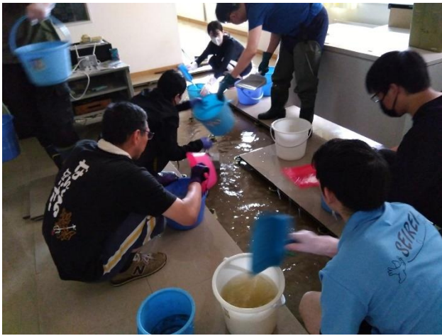
OAフロア床下水の汲み取り作業
